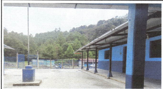
Foto 2: Losa de patio rehabilitada en su totalidad, 90 metros cuadrados remozados.
