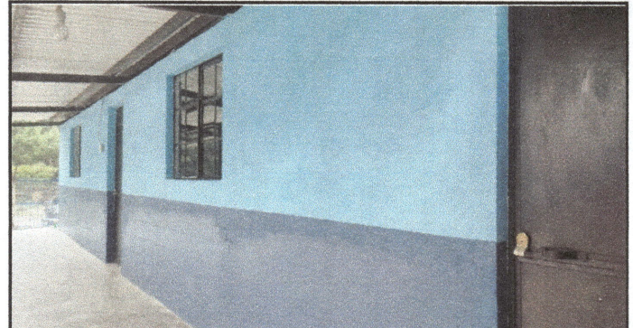
Foto 8: Las paredes exteriores de la parte frontal de aulas resanadas, repelladas y pintadas en su totalidad.
