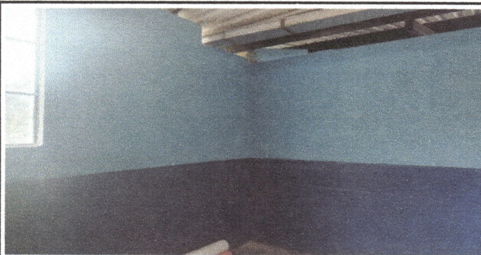
Foto 5: Aula 1 del modulo 1, con las paredes repelladas y pintadas en su totalidad.
