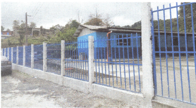
Foto 3: Muro perimetral, baranda de metal sustituida lo que garantiza una durabilidad por mas años.
