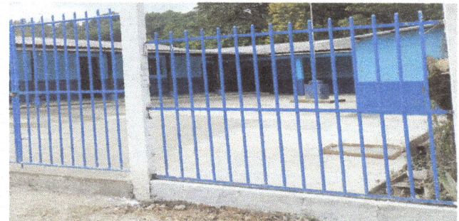
Foto 4: Barandas de metal instaladas, lo que garantiza una mejor seguridad a todos los niños en el centro educativo.
